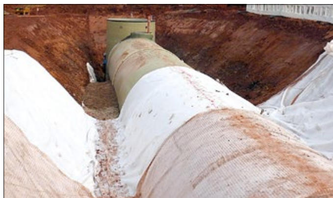
Bau eines Stauraumkanal in Etterwinden Foto: ZV HOMU
