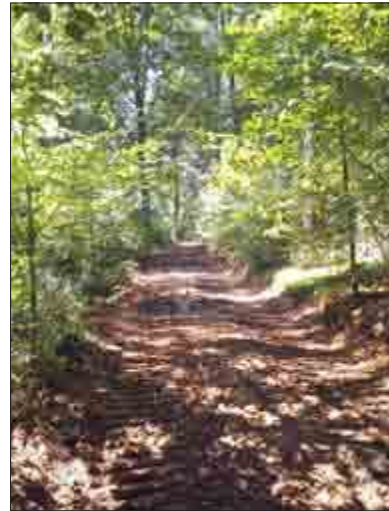
instandgesetzter Waldweg (Maschinenweg)
